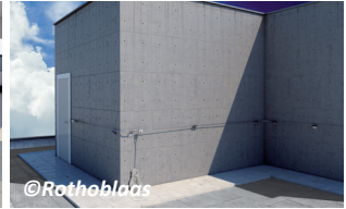
Anschlagvorrichtungssystem entlang einer Wand; beim Überqueren der Zwischenverankerungspunkte muss der Benutzer nicht sein Absicherungsseil aus- und wieder einhängen – also eine mögliche Fehlerquelle weniger...
