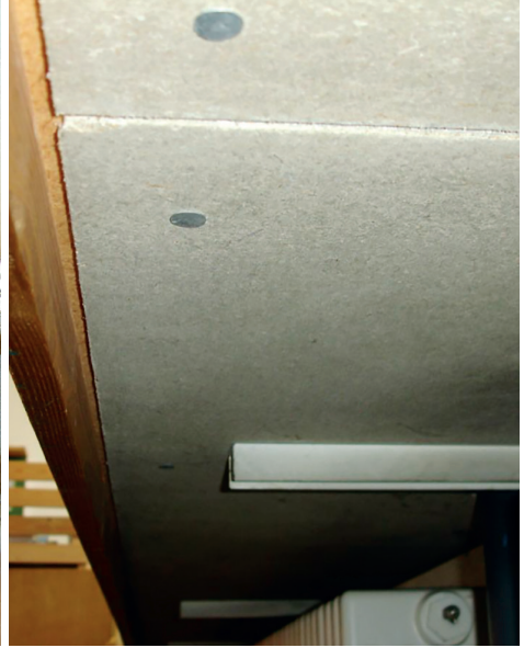
Asbesthaltige Leichtbauplatten unter Fenstersimsen
