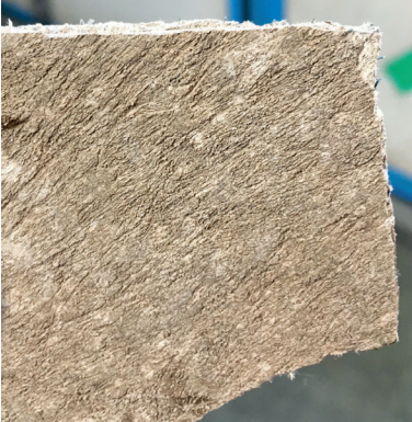
Teil einer gebrochenen Asbestplatte
