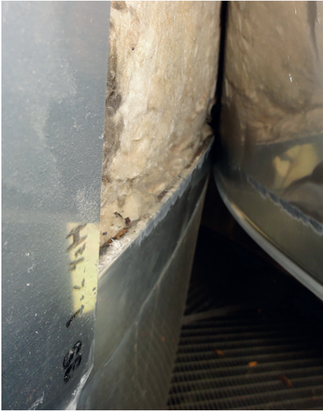
Asbestisolierter Boiler
