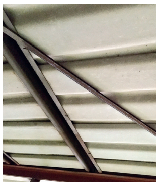
Dachplatten aus Asbest
