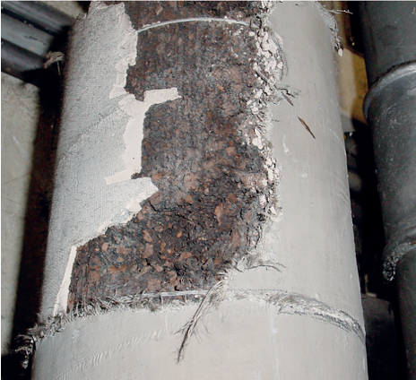
Asbestisolierte Rohre
