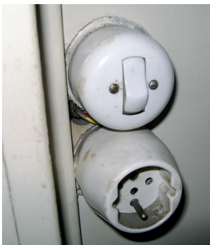
Asbesthaltige Schalterisolation
