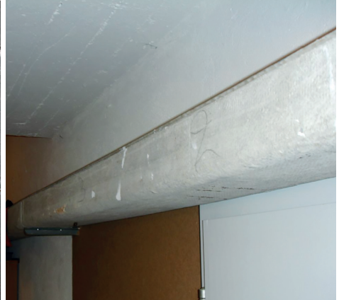
Asbesthaltige Leichtbauplatten unter Fenstersimsen
