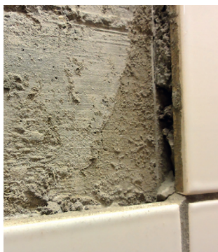
Asbesthaltiger Plattenkleber
