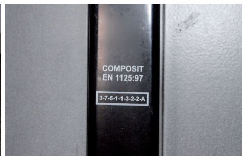
Kennzeichnung einer Öffnungsvorrichtung laut EN 1125 an der Schließeinrichtung selbst.
