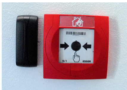
Kennzeichnung eines Druckknopfmelder zum Brandalarm
