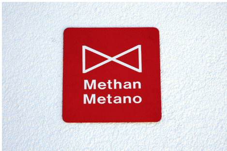
Information zum Gasschieber im Betrieb
