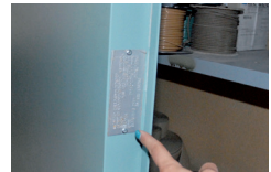
Kennzeichnungstafel mit Angabe der Brandwiderstandsdauer an einem Brandabschluss.
