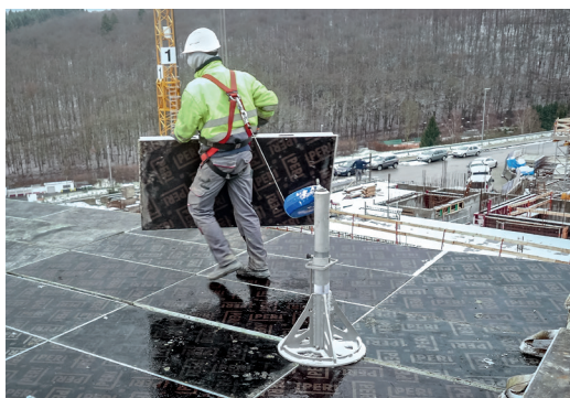
(Quelle PERI) Spezielle Herstellerlösung zur Absturzsicherung mittels PSA und genormten Verankerungspunkt
