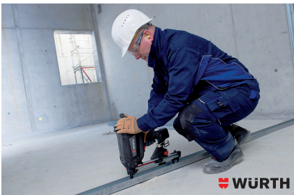
(Quelle Würth) Verwendung eines Bolzenschubgerätes unter Berücksichtigung der PSA
