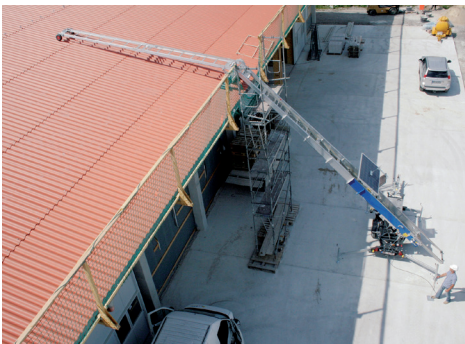
Aufzugsfahrbahn bis auf das Dach
