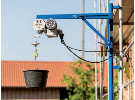
(Quelle: Böker) Aufzugsmontage am einem Fassadengerüst
