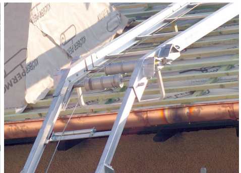
Knickpunkt und Auflager am Dach
