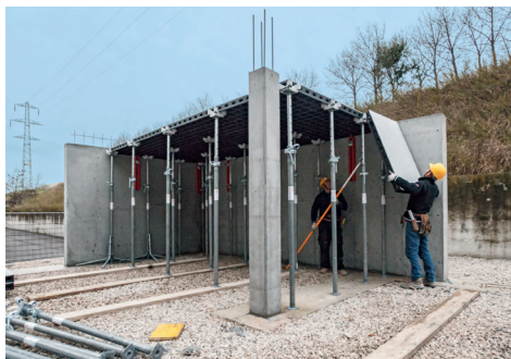
(Quelle PERI) Schalungsaufbau vom Boden oder von der Schalung aus
