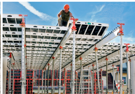
(Quelle PERI) Schalungsaufbau vom Boden oder von der Schalung aus
