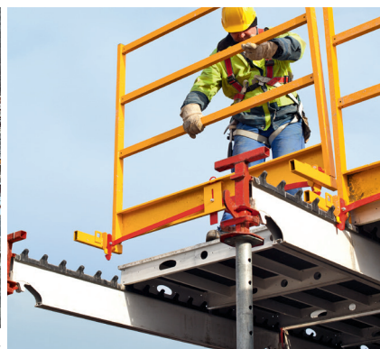
(Quelle PERI) Parapetteinsatz auf Deckenschalung
